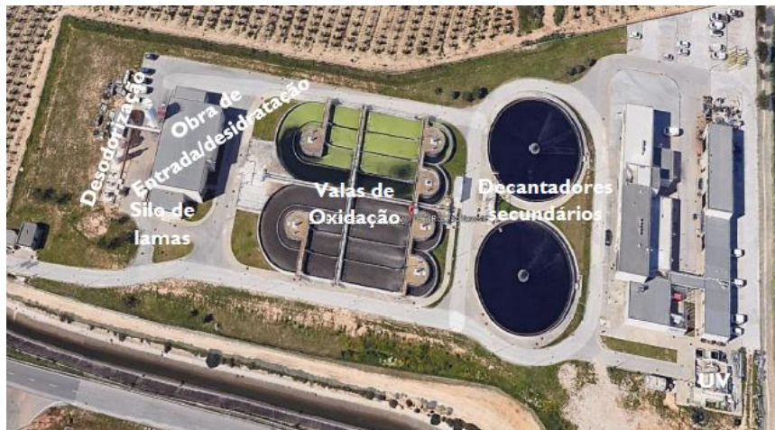
Figura 1 - Vista aérea do recinto da ETAR de Faro Noroeste.
